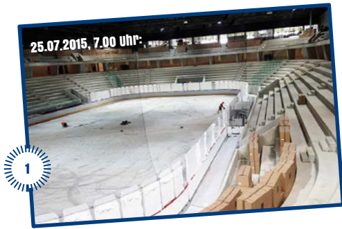
Die ZüKo übernimmt die Eishalle mit der ersten Eisschicht von vier Millimeter Dicke. Mit Jet-Ice Eisfarbe wird das Grundeis weiss gefärbt und versiegelt.
