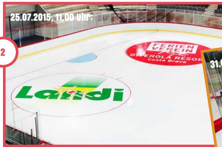
Darauf werden die Vlies-Eiswerbungen verlegt. Das Vlies wird im Auftrag der ZüKo in Schweden hergestellt. Die Linien für das Eishockeyfeld werden genau vermessen und markiert. In den folgenden Tagen wurde dann eine drei Zentimeter dicke Eisschicht darüber aufgebaut.
